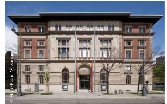
EINGANG GENUSSWELTEN GEBÄUDE WEISKIRCHNERSTRASSE
